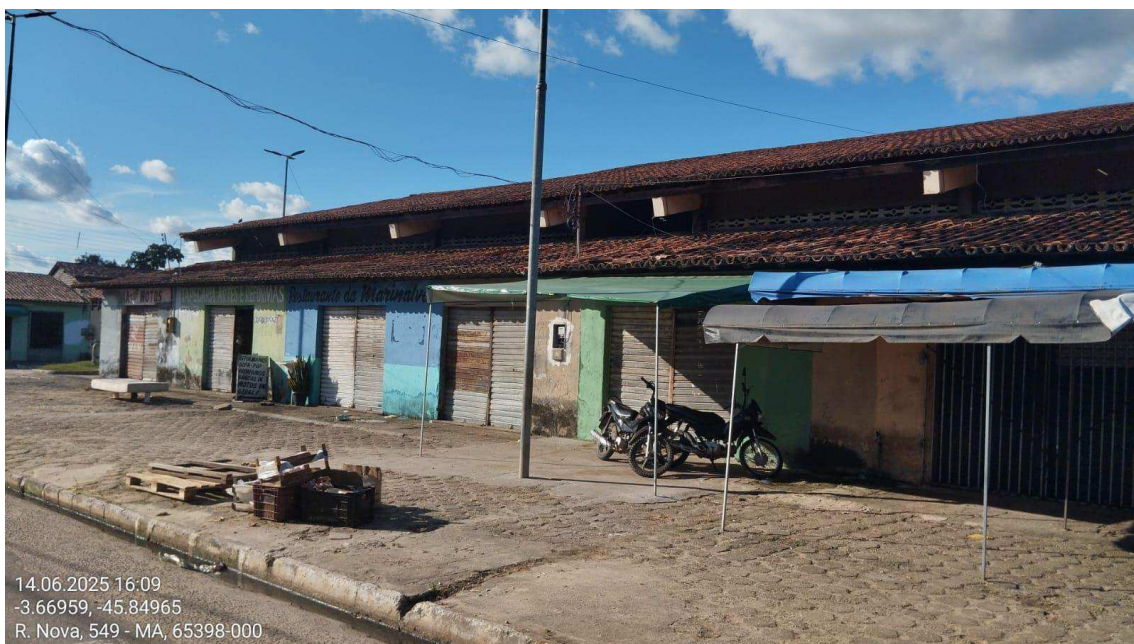
Figura 24: Fachada lateral esquerda
