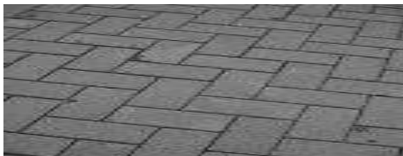
Blocos intertravados de concreto.
