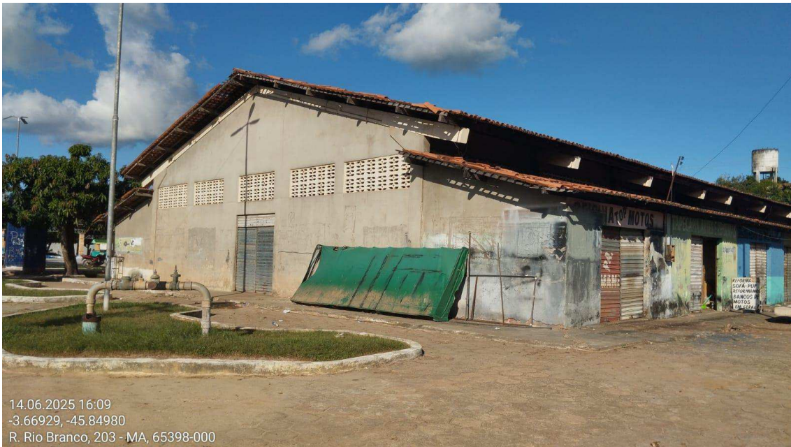
Figura 21: Imagem externa, fachada posterior
