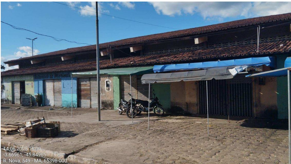
Figura 22: Fachada lateral esquerda
