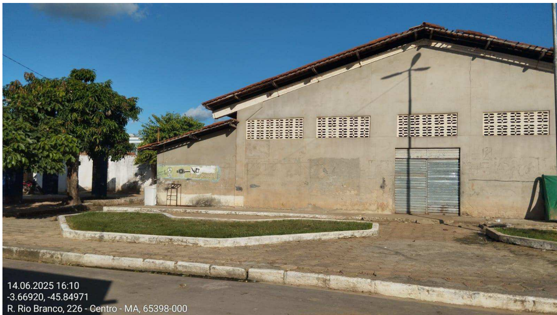
Figura 16: Imagem externa, fachada posterior
