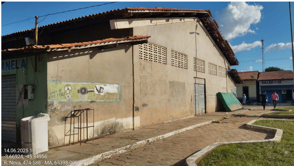
Figura 14: Imagem externa, fachada posterior
