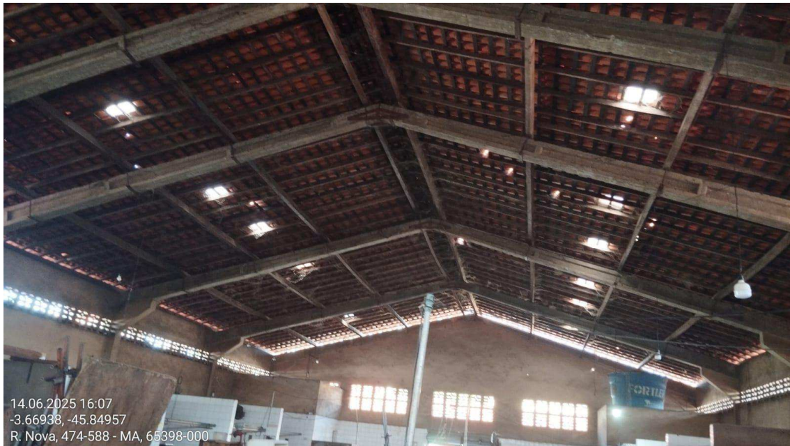
Figura 31: imagem da cobertura
