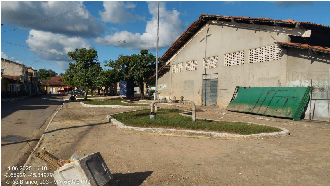
Figura 19: Imagem externa, fachada posterior e poço
